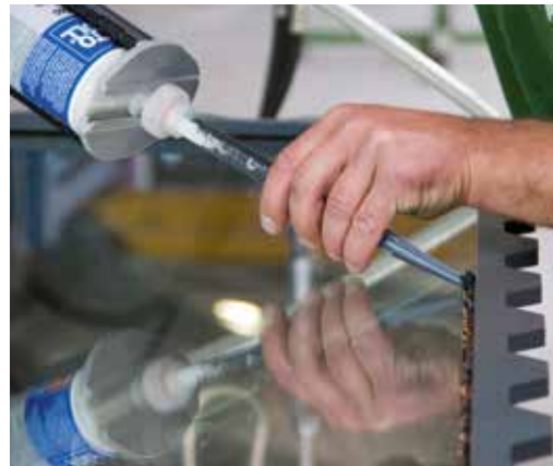
Einbringen des 2K Silicons für Holz-Glas-Verbundelemente
