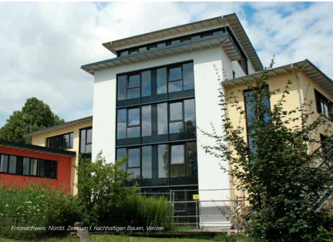
HOLZ-GLAS-VERBUNDELEMENTE AM OTTO-GEBÄUDE
